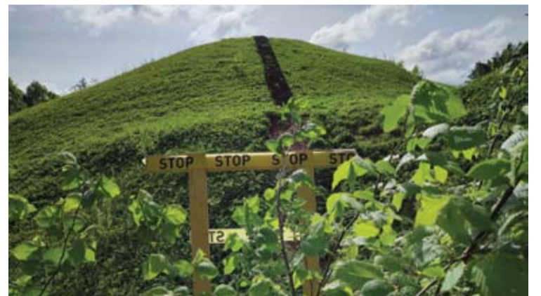
Laiptai ant Šeimyniškių piliakalnio sutrūniję, klebantys, netvirtintys turėklų, o šlapi dar ir slidūs.
